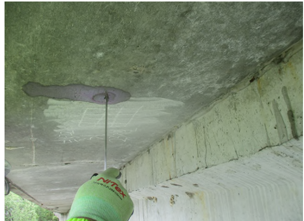
탄산화깊이 측정 현황
